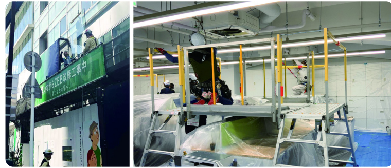
使いながら改修工事の様子
