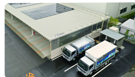
太陽光発電で充電中のEVパッカー車
