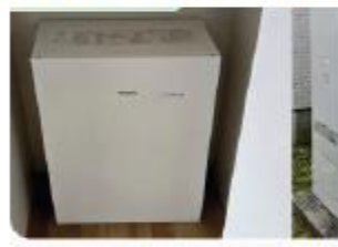
施工：東北電力eソライフ(株)
